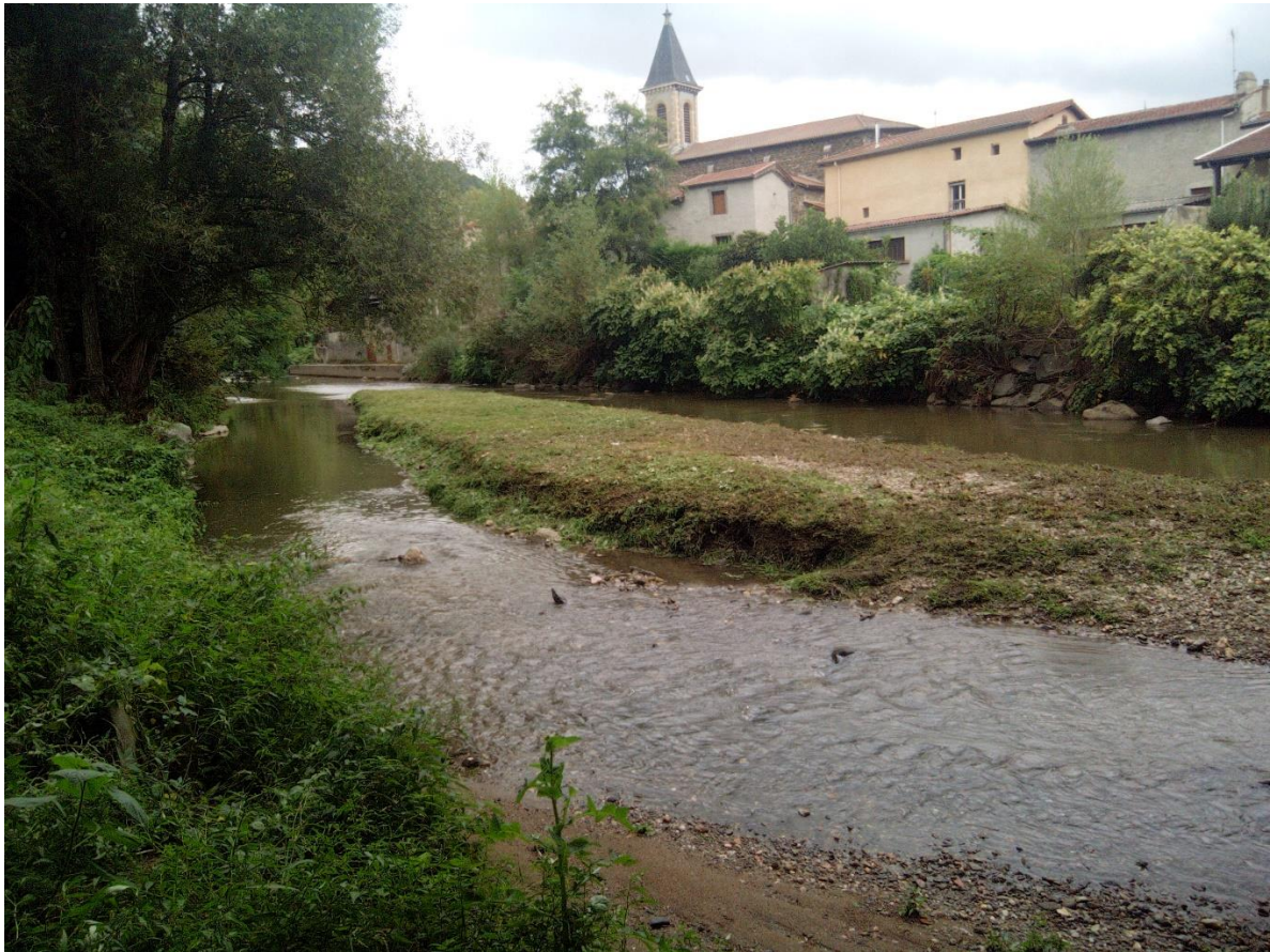
Fauche de l'atterrissement aval du pont de Saint-Romain-en-Gier
