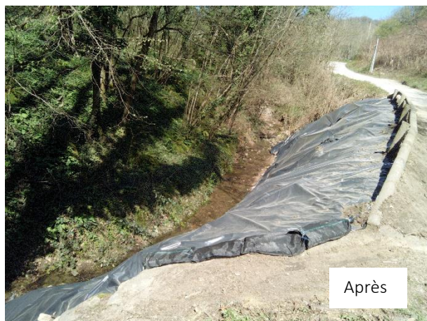
Les phases d'installation d'une bache en lutte sur la Renouée du Japon sur le Barny
