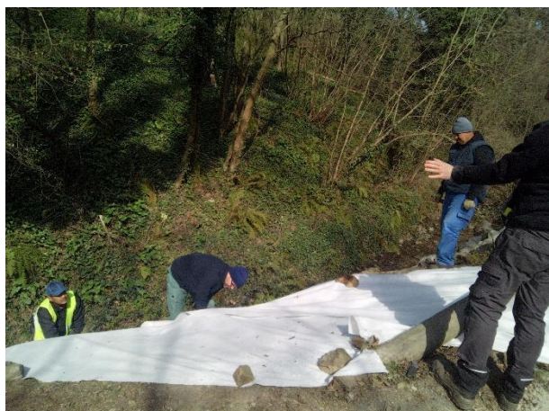
Les phases d'installation d'une bache en lutte sur la Renouée du Japon sur le Barny
