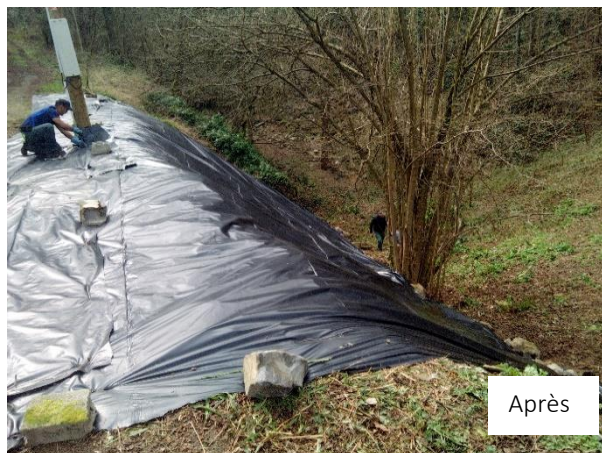
Les phases d'installation d'une bache en lutte sur la Renouée du Japon sur le Chatanay
